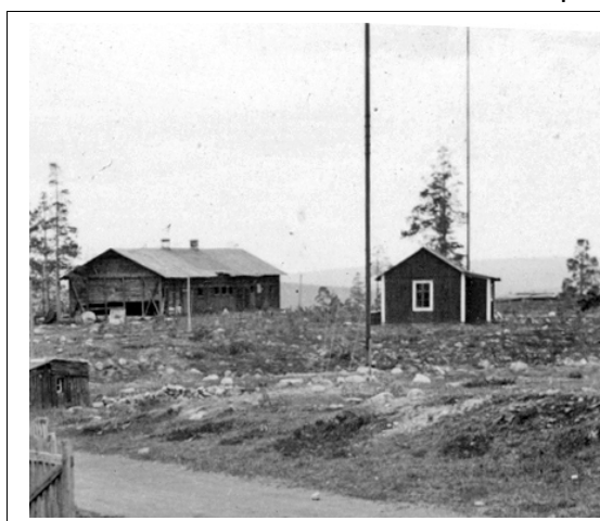
Radiostationen med sina två ca 60 m höga trä- master var och en gjord av tre trästolpar.
